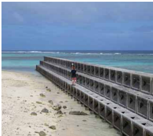
Examen de la digue de protection du port dans le quartier de Nikao, à Avarua, sur l'île de Rarotonga (Îles Cook).
