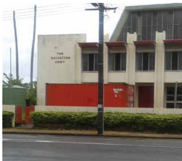
Centre d'évacuation de l'Armée du Salut, avec son conteneur et son réservoir d'eau.
