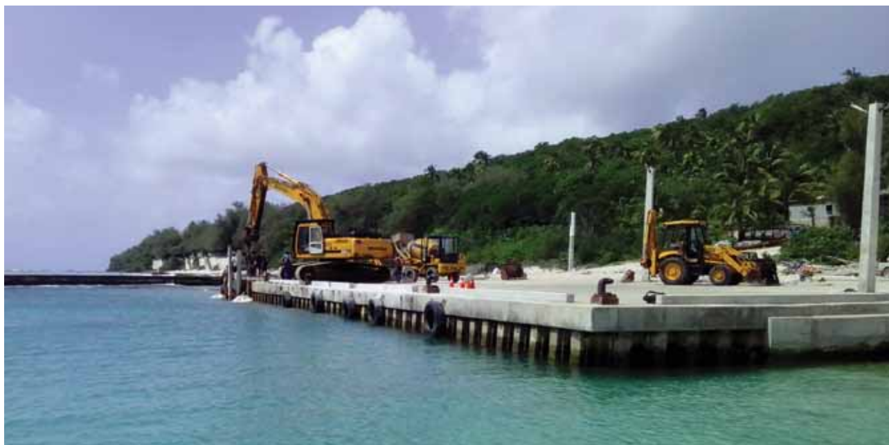
Construction du port de Mangaia (Îles Cook).
