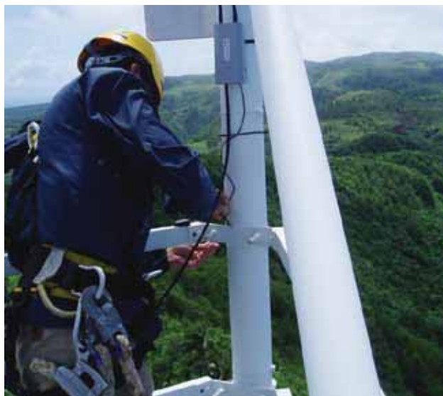
Travaux d'extension du réseau par Radiocom, Futuna.
