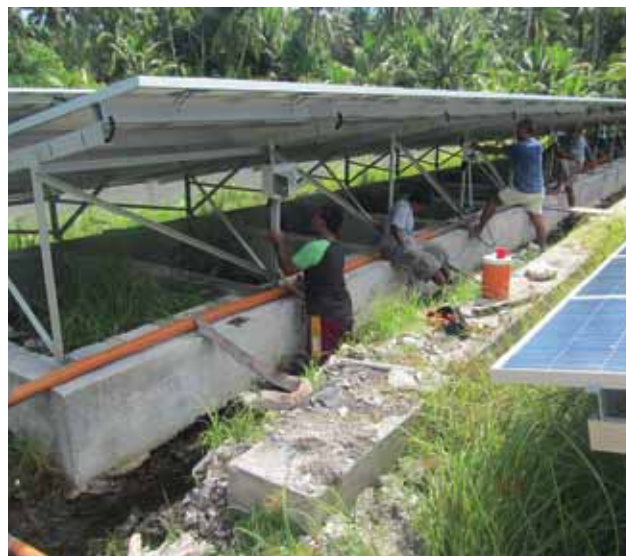
Raccordement de câbles sur l'installation photovoltaïque par des techniciens locaux.
