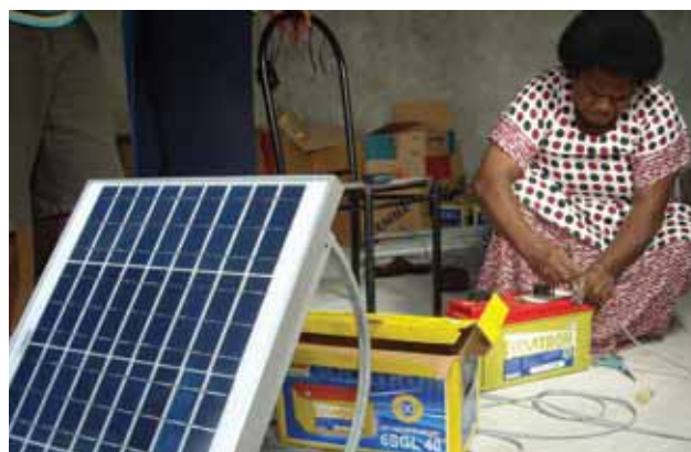
Panneau solaire qui alimentera le déshydrateur. Crédit photo : ONU Femmes.
